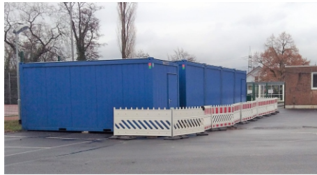
Schon heute muss ein Teil des Unterrichts in Containern stattfinden.
