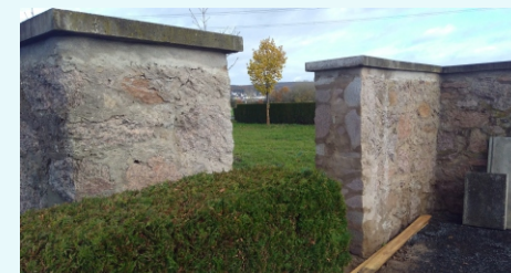
Die neue Öffnung der Friedhofsmauer zum Bereich der Baumbestattungen. ■
