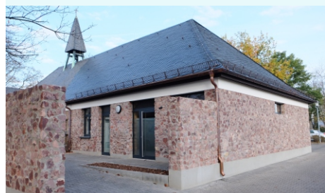
Der neu errichtete Anbau beherbergt u.a. per Zahlencode von außen zugängliche Aufbahrungsräume.
