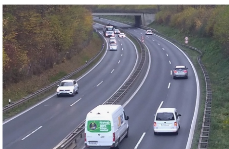
Die B496 bei Stockstadt: Mangelnde Verkehrssicherheit u.a. durch fehlende Standstreifen.
