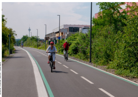
Radschnellweg optimal auf separater Spur mit Asphaltbelag und Beleuchtung
