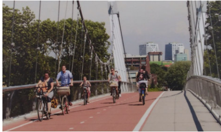
Nicht nur in den Städten wird dem wachsenden Radverkehr zunehmend auch durch eigene Brücken Rechnung getragen.
