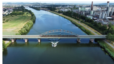
Die Chancen für eine neue Fußgänger- und Radfahrerbrücke neben der bestehenden Eisenbahnbrücke sind gestiegen.
